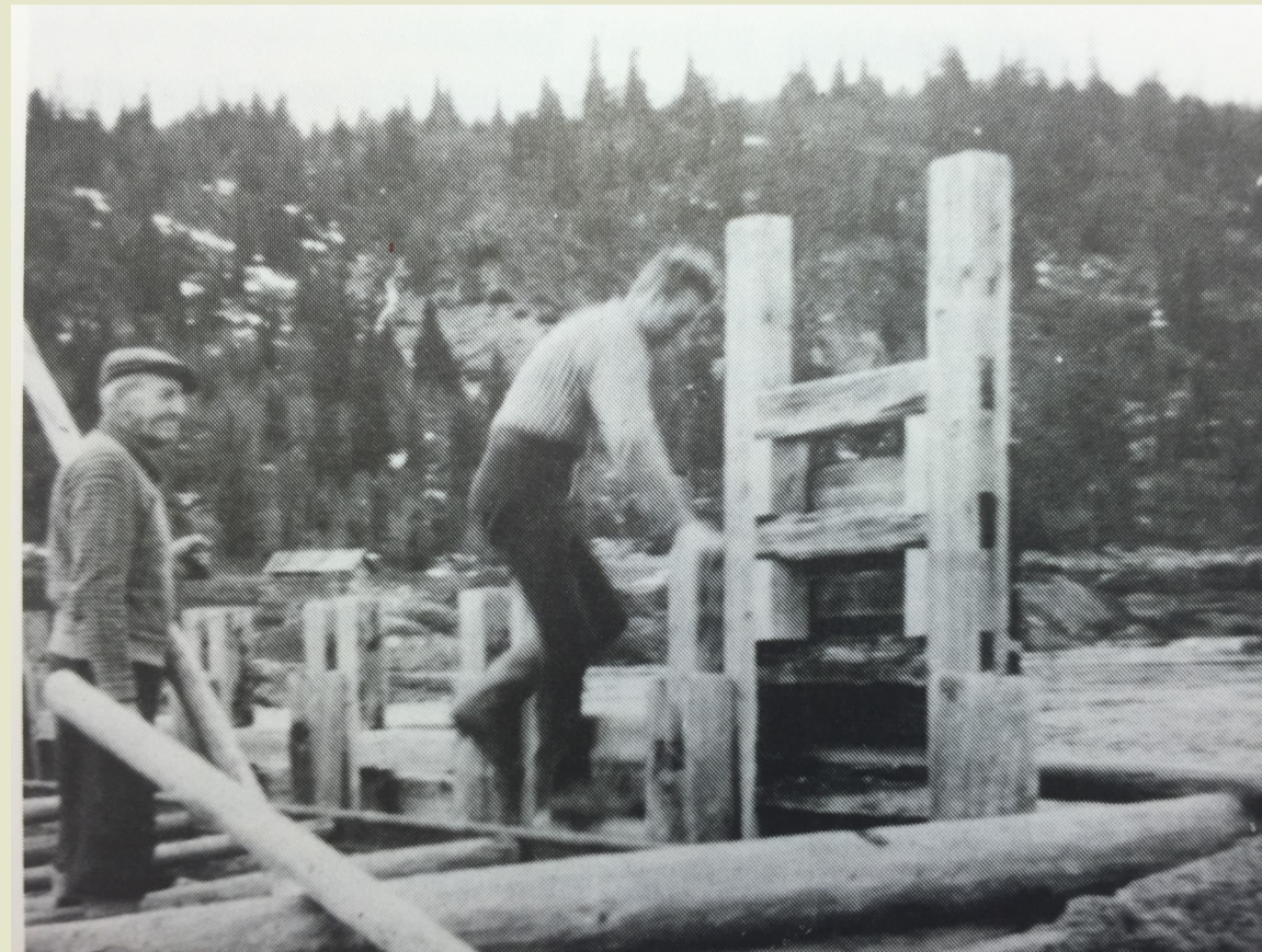
Ingvald Berg og Jon Steinsvold i arbeid på Etnesenn dammen ca. 1960.
