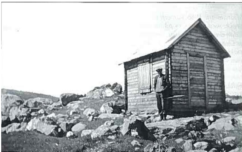
Mangeåring damvoktar Ingvald Berg ved damvoktarhytta. Frå Brøtningen skal fram, Etna Fellesfløtningforening, Harald Hvattum 1999.
