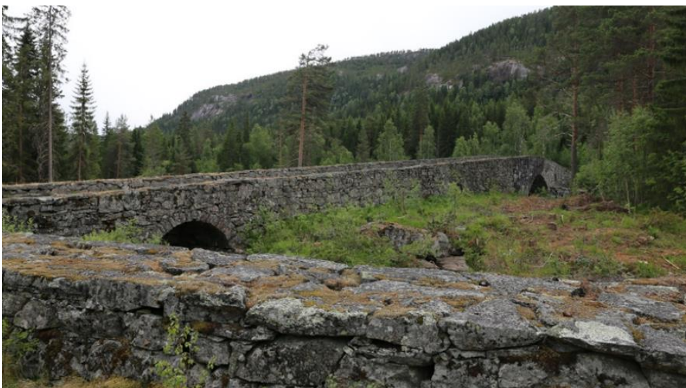
Lundebrua er 132 meter lang. Foto: Etnedal kommune.
