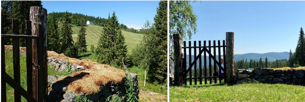
Biletet til venstre viser noko av muren og porten. I bakgrunnen ser vi det kvite våningshust på Nerre Hestekind, og lengre til høgre skimtar vi gardstunet på Breie. Foto: Etnedal kommune. Biletet til høgre syner den restaurerte porten, fotografert frå innsida av gravplassen. Foto: Ole Aastad Bråten.
