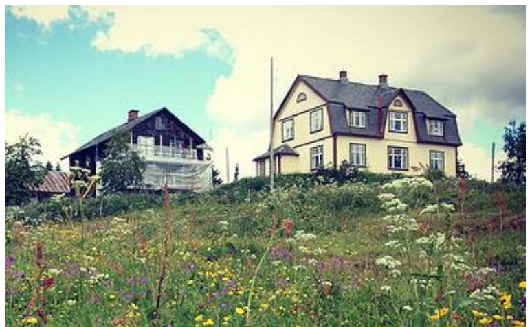
Tunet på Breie ligg eksponert til i terrenget. Gulbygningen har trekk både frå jugendstil og nybarokk. Kontrasten er tydeleg til den upanelte gamlebygningen, som er under restaurering. Foto: Inger Toril Holte Breie.
