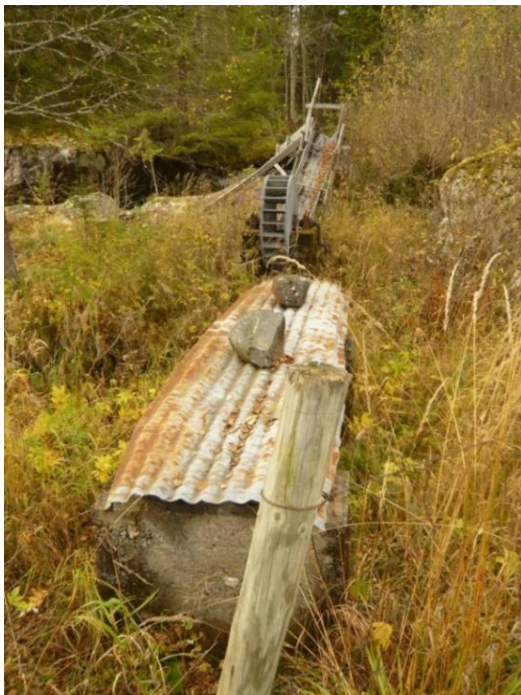
Flishøvel under bølglekket (til venstre) og ledemur (til høyre). Foto: Katharina Sparstad.
