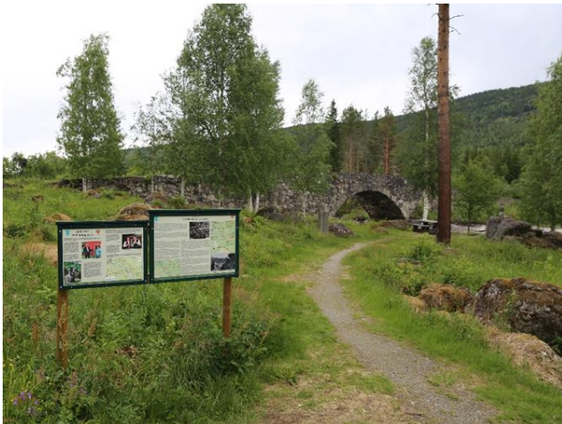
Nedanfor Lundebrua er eit tilrettelagt rasteområde med informasjon om brua og området. Foto: Etnedal kommune.
