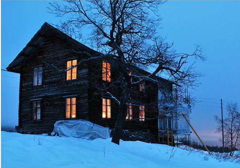
Gamlebygningen er under restaurering. Foto: Inger Toril Holte Breien.
