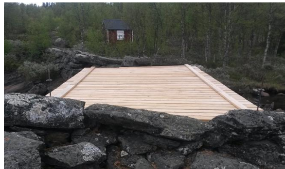
Etter opprusting av dammen i 2015. Den restaurerte damvoktarhytta kan ein sjå i bakgrunnen. Foto: Kristen Hagaseth.
