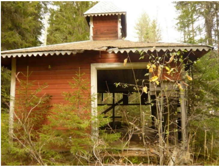
Hovde lysverk hausten 2017. Foto: Katharina Sparstad.
