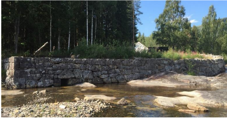
Muren som leidde vatnet inn på lysverket framstår framleis solid og markant langs elva. Foto: Etnedal kommune.
