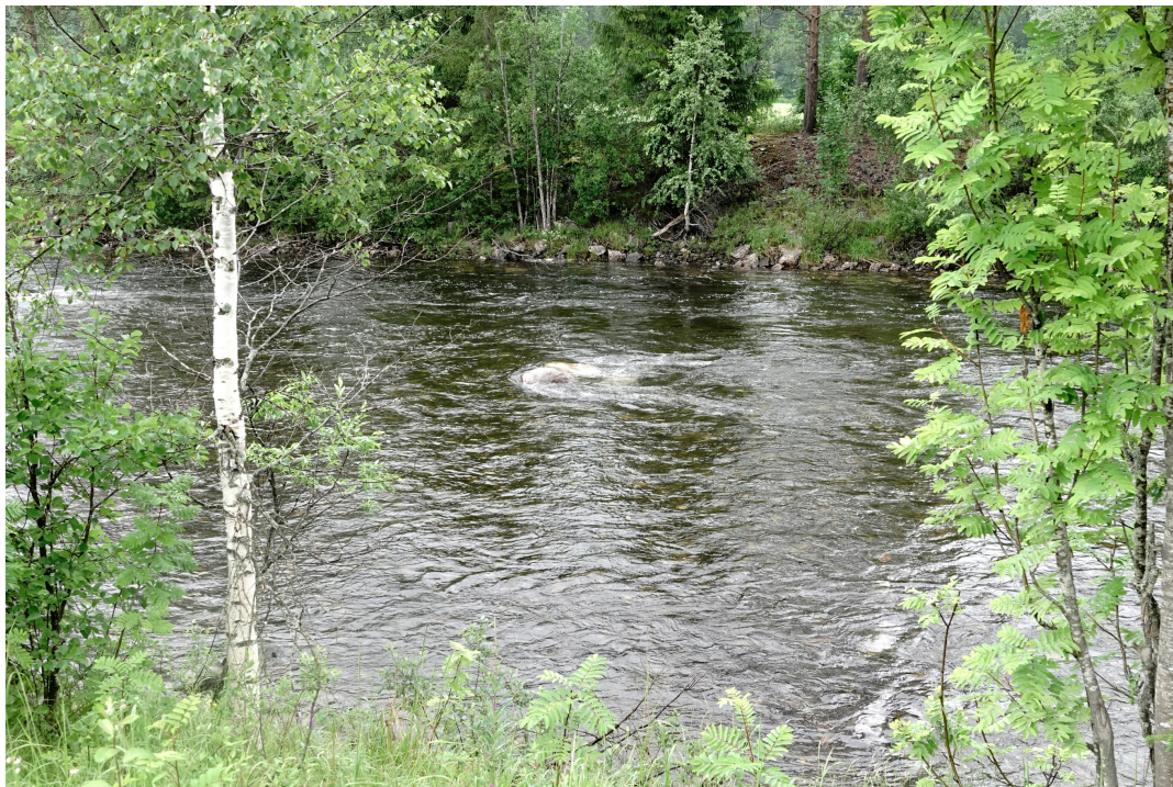
Figur 4 Nylig lagt ut stein i Etna under høstflom. Steinen reduserer vannhastigheten lokalt (G. Høitomt 2022)
