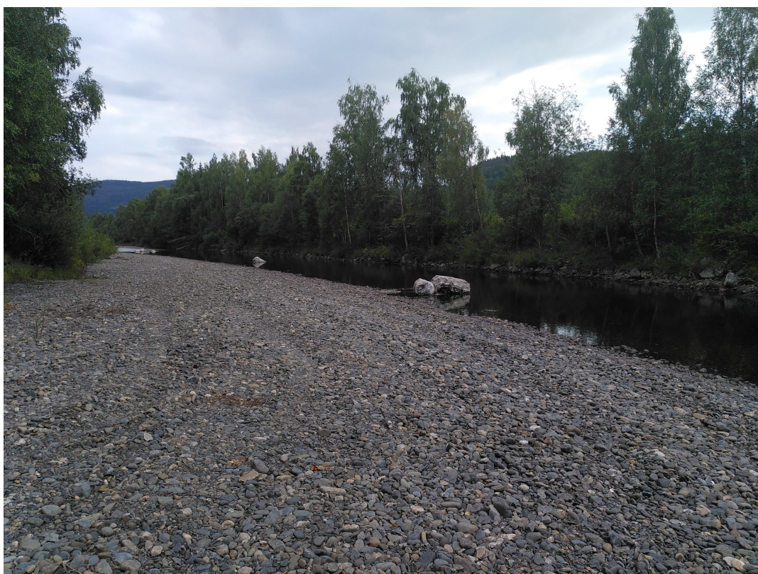
Figur 5 Stein lagt ut i Etna ved Lundby i august 2022. Bildet er tatt før steinene ble endelig plassert (L. Hoch 2022)
